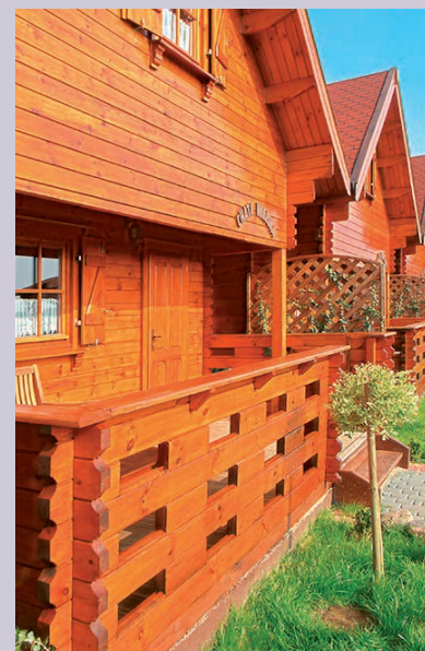
Elewacja pomalowana Lazurą ochronną V33
