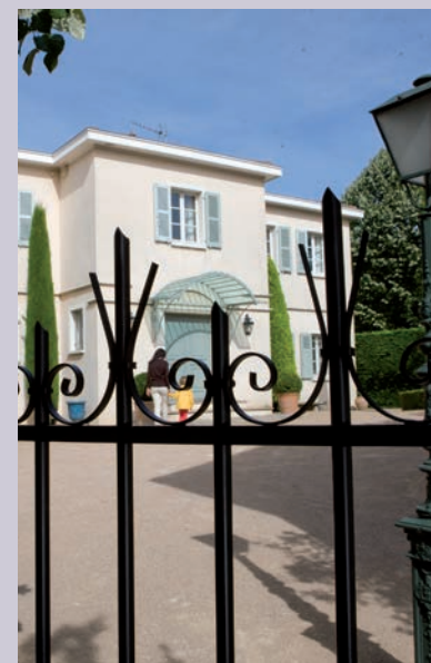
Ogrodzenie pomalowano Farbą do metalu V33 bezpośrednio na rdzę
